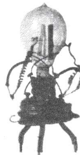
Figuur 36. Lamp van Fleming met oscillatorschakeling van Armstrong
